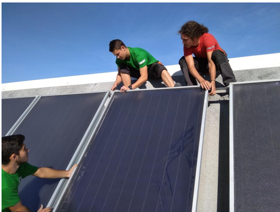
nasi uczniowie montują kolektor słoneczny na dachu budynku
