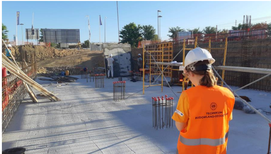
Kasia z kl. III G wykonuje pomiary geodezyjne na budowie
